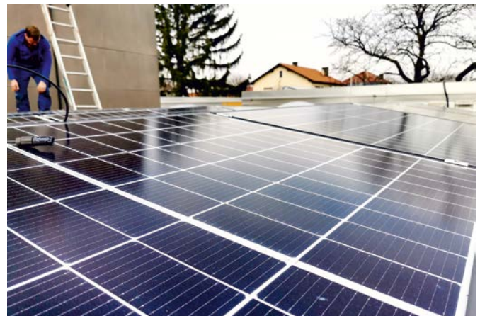
PV Anlage in Fertigstellung-Detail
